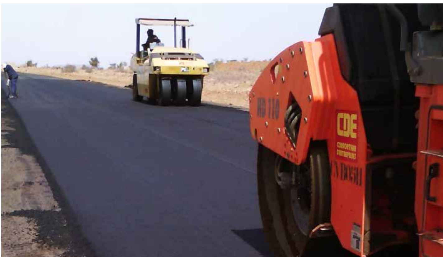
Enrobe tronçon Rastaref-Aoujeft (MAURITANIE)
