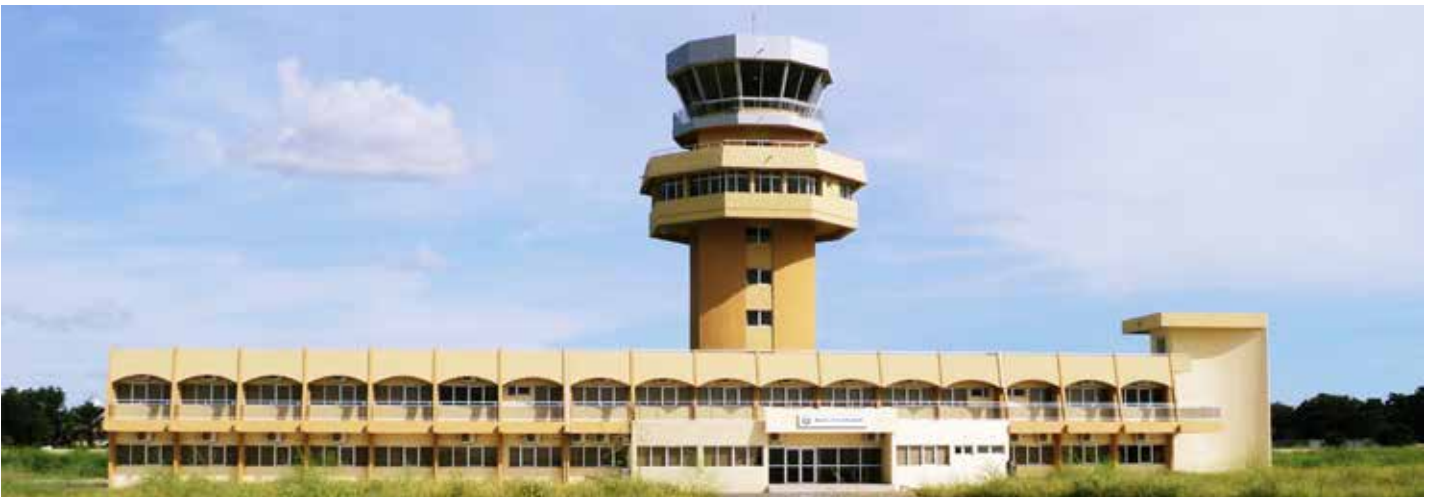
Tour de contrôle de l'aéroport de NDJAMENA (TCHAD)
