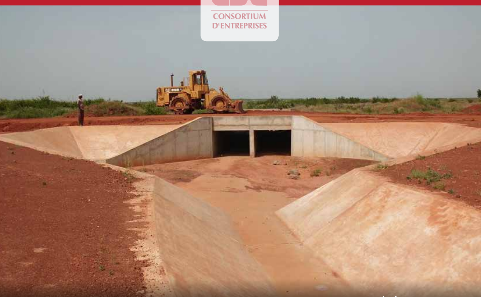
Raccordement fossé de drainage des eaux pluviales et dalot à AIBD (SÉNÉGAL)
